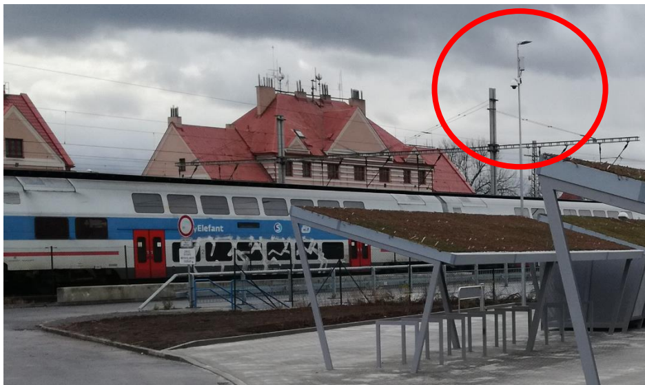
Obr. 7 Ukázka kombinace osvětlení a kamerového systému na stožáru u B+R Český Brod
