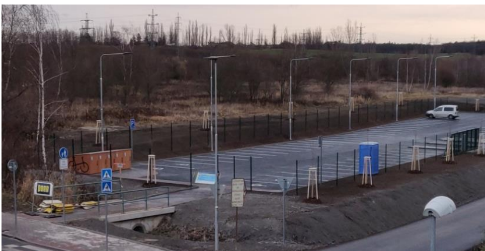
Obr. 9 Ukázka umístění výsadby stromů podélně okolo parkoviště P+R v Praze-Běchovicích
