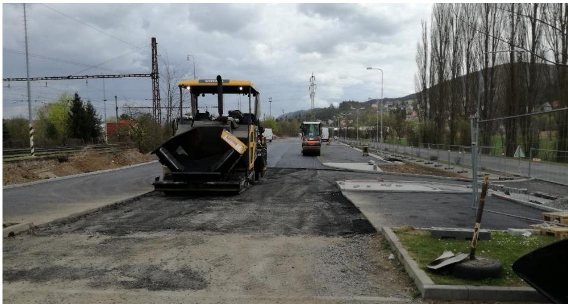
Obr. 2 Ukázka aplikace asfaltového povrchu v rámci parkoviště P+R v Dobřichovicích
