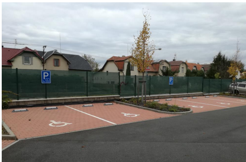
Obr. 11 Ukázka provedení parkovacích míst pro invalidy na parkovišti P+R v Českém Brodě
